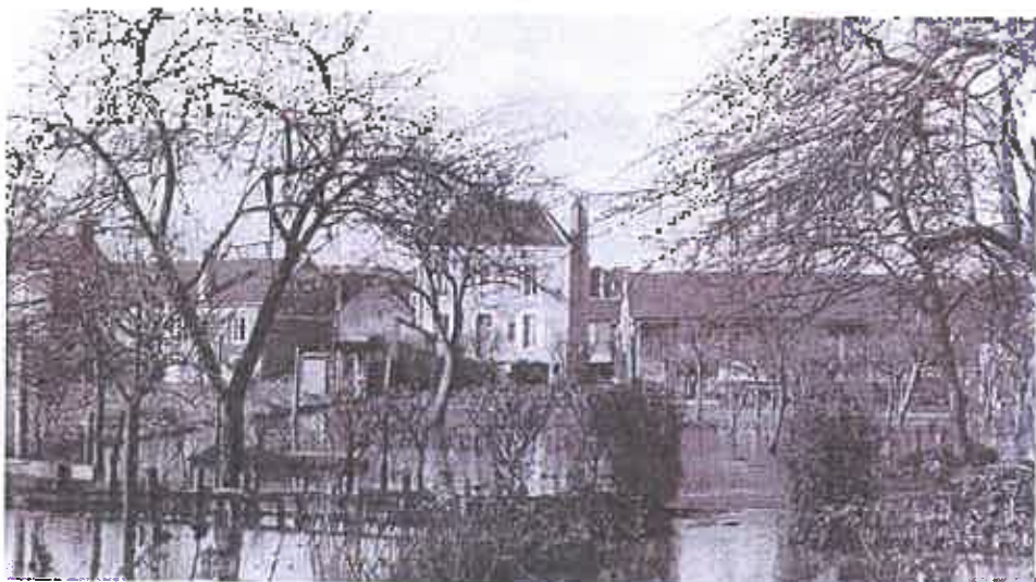
Crue du 7 janvier 1968
