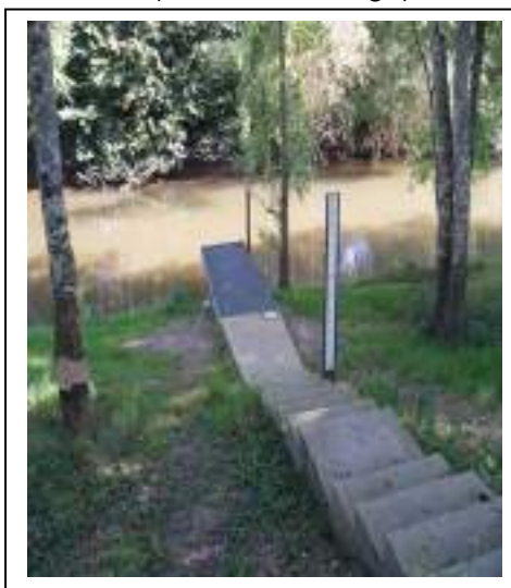
Photo de la station de jaugeage de Salbris
